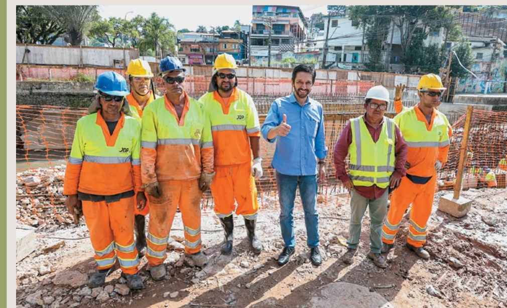
Onde o povo está: No alto, durante visita a Cidade Tiradentes, bairro periférico. Acima, na vistoria das obras de combate às enchentes na região do Ribeirão Perus, Zona Norte
